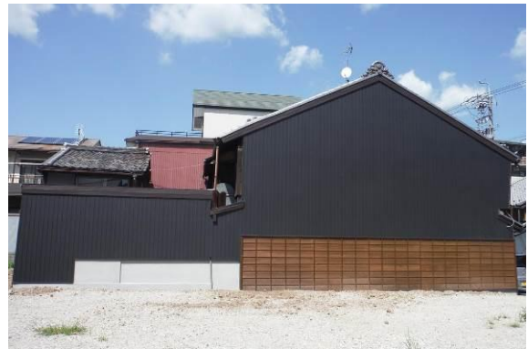
屋根一部補修、樋補修、外壁改修、物干し台撤去
