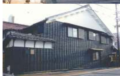
【改修内容】屋根一部差替え、窓格子補修、外壁補修、室外機カバー設置。
