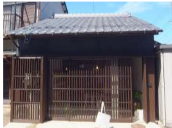
【改修内容】屋根葺き替え、格子戸設置、外壁改修、室外機カバー設置。
