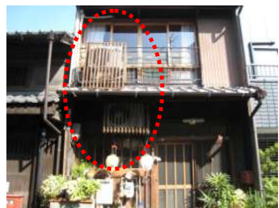
【改修内容】 室外機力バー設置
