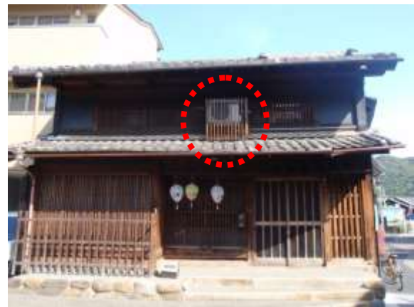
【改修内容】 室外機カバー設置
