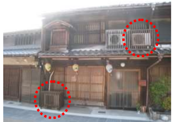
【改修内容】 室外機カバー設置
