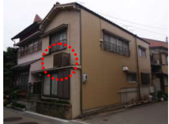
【改修内容】 室外機力バー設置
