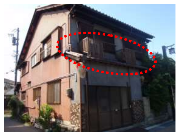
【改修内容】 室外機カバー設置
