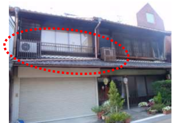
【改修内容】 室外機力バー設置
