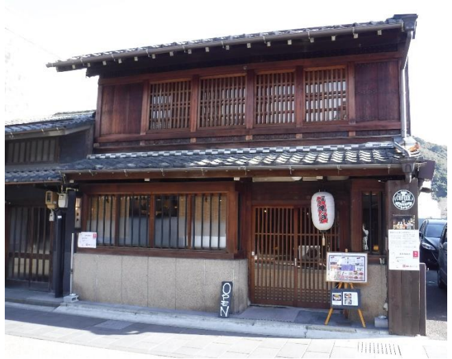
【改修内容】外壁塗装、瓦屋根一部補修、内装改修（空調・給排水の設備工事）
