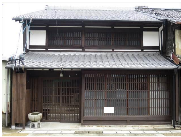
【改修内容】屋根葺き替え、樋取替え、格子塗替え、漆喰やり替え、玄関引き戸設置、窓サッシ取替え
