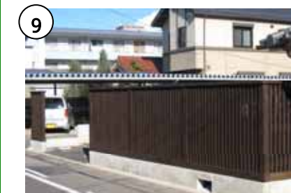
伝統的素材を用いた塀の設置
