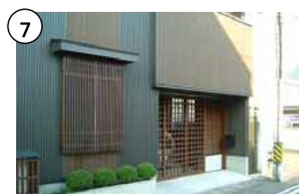
一般建築物への木製格子の新設
