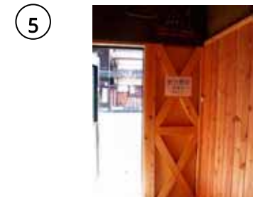
歴史的建築物への筋交い等の設置
